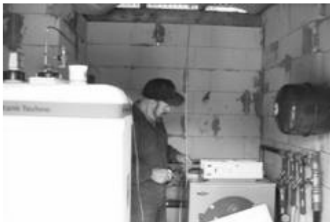
Hptm a.D. Hans Husmann im Heizungskeller bei der Elektroinstallation
